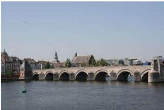
Maastricht, Sint Servaasbrug.
