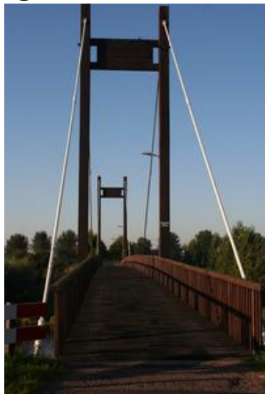
Fietsbrug rivier Mark
